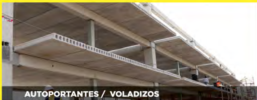
MENOR MANO DE OBRA
